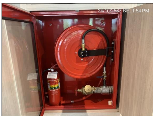
ภาพที่ 30 ถังดับเพลิง และป้ายแนะนำการใช้
